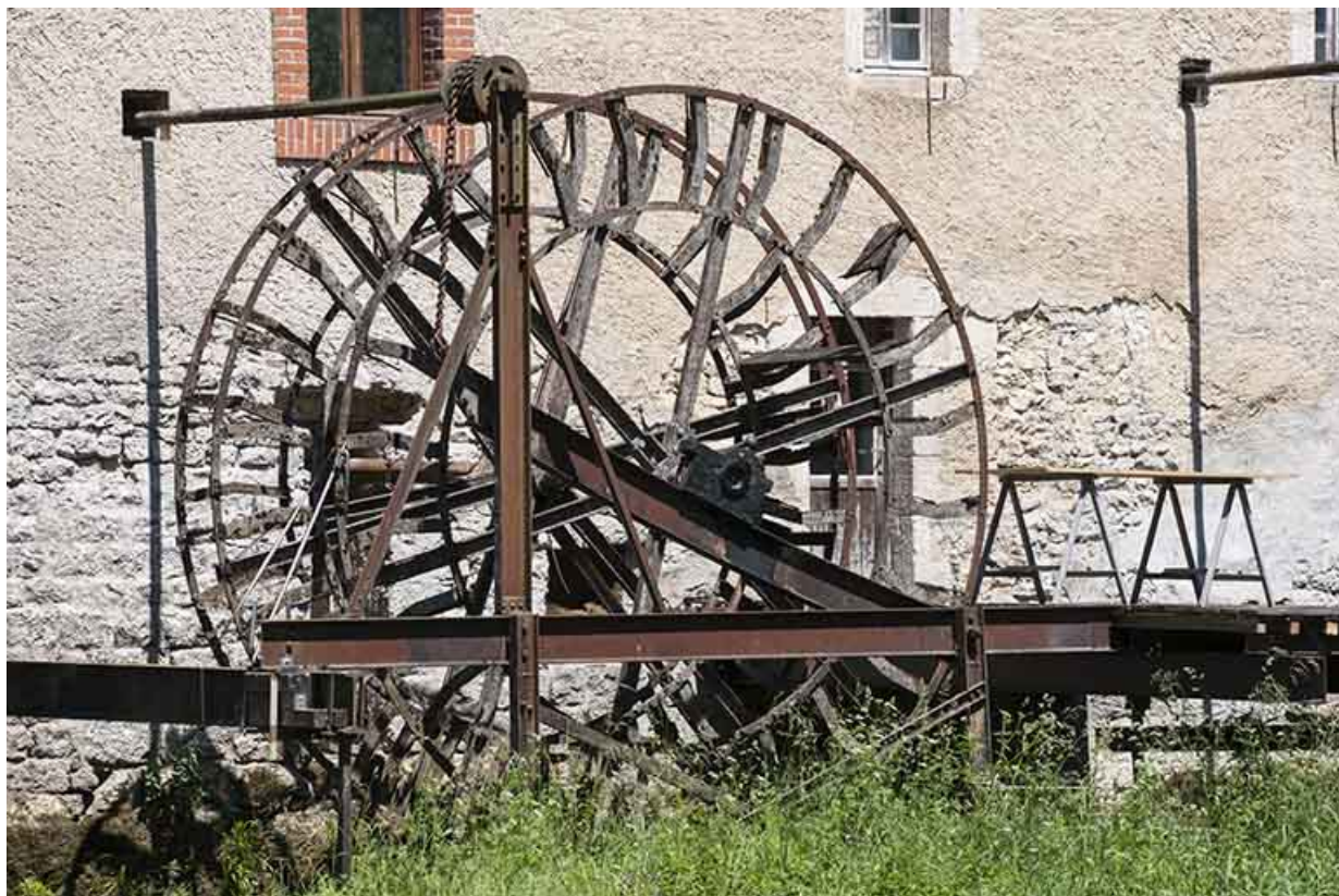
Roue hydraulique aval depuis la rive droite.
