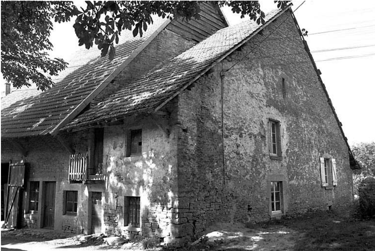
Façade antérieure et face latérale droite.
