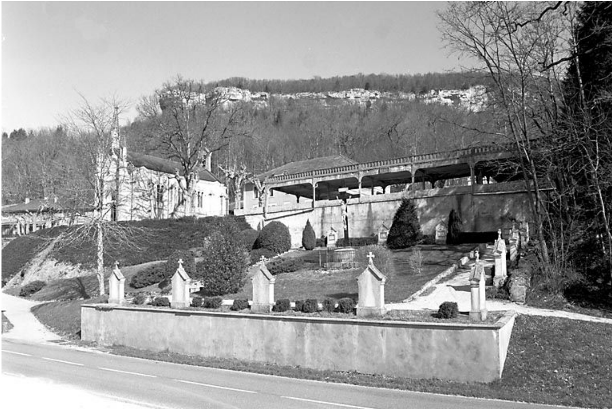
Vue d'ensemble depuis la D 101.
