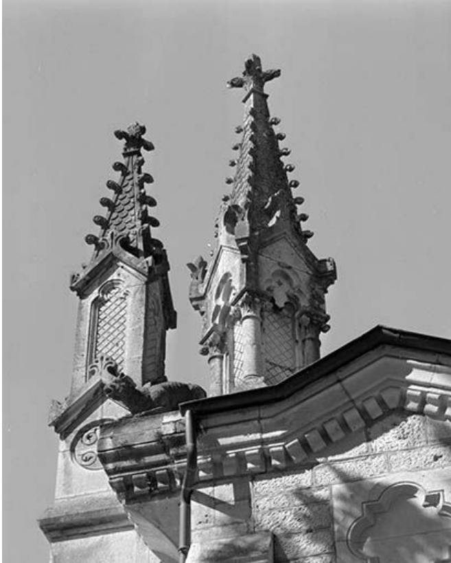
Façade antérieure, détail : les clochetons.
