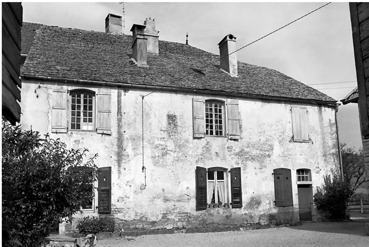
Façade antérieure. 25, Scey-Maisières
