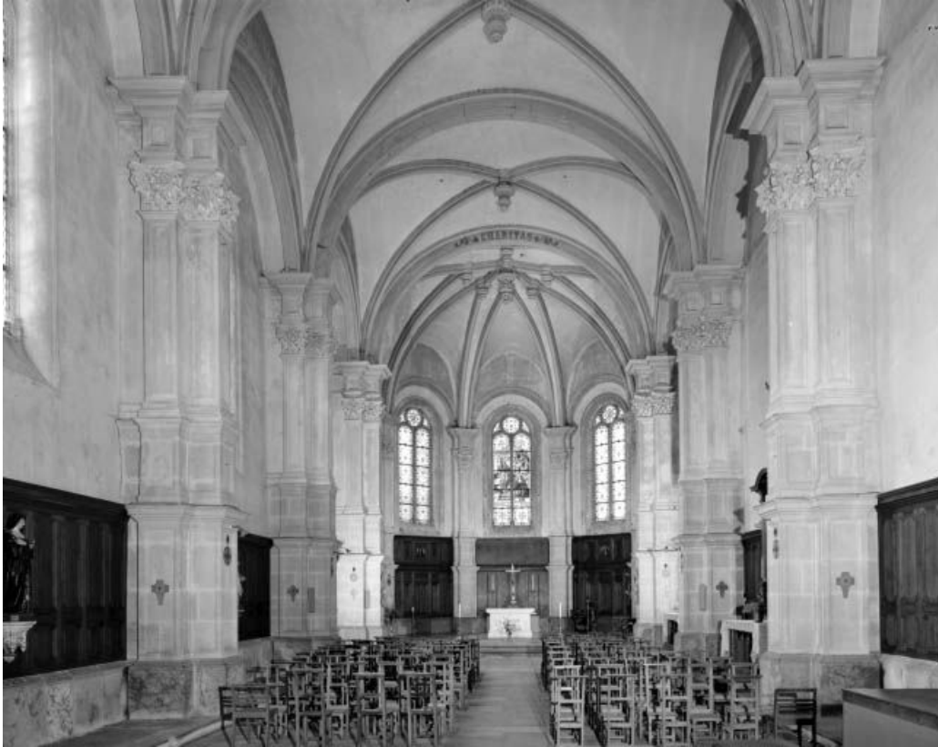
Intérieur : la nef et le chœur.
