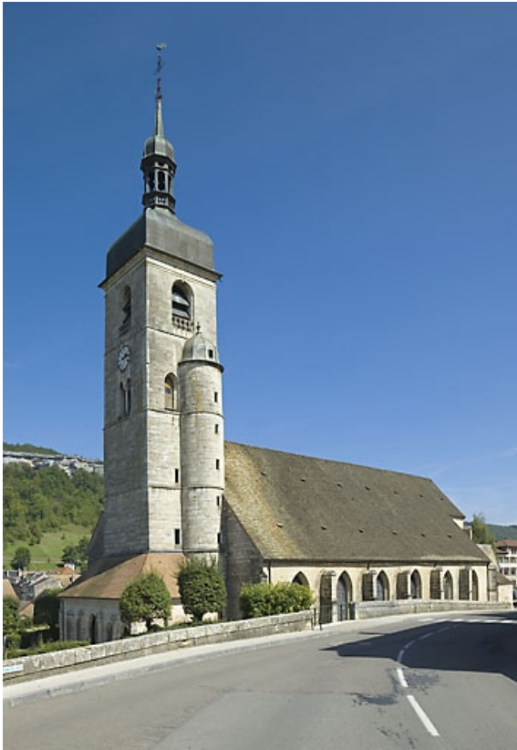
Vue de la tour-clocher.
