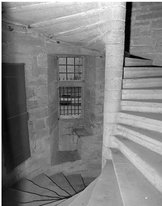
Intérieur : escalier baie du rez-de-chaussée.
