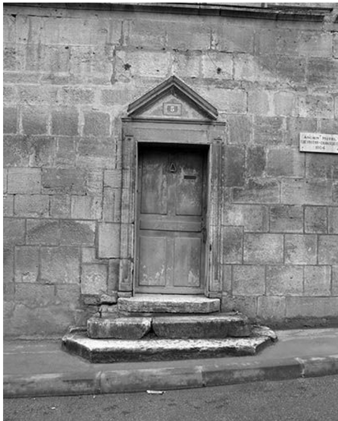
Façade antérieure : porte d'entrée.
