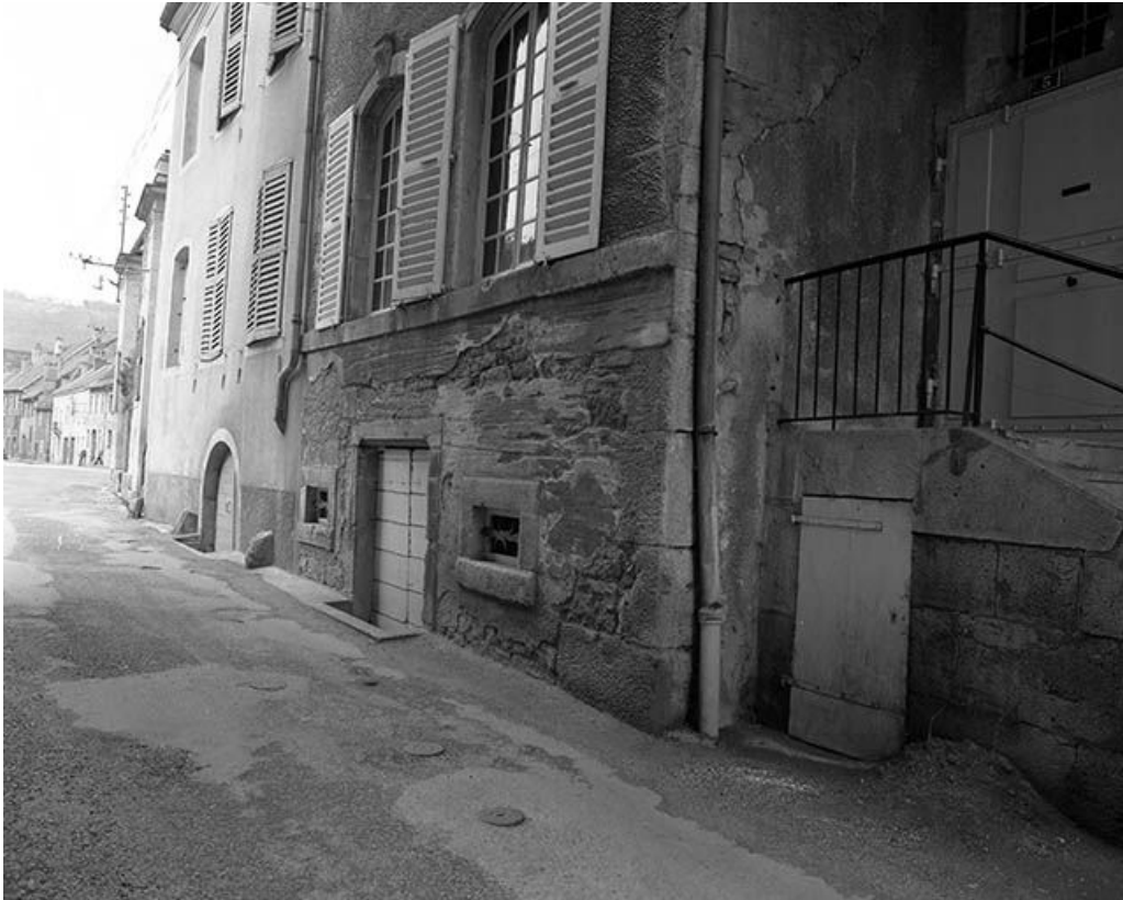
Façade antérieure : le rez-de-chaussée et le sous-sol.
