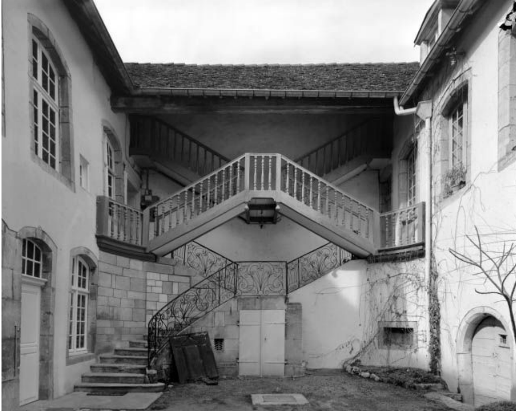
Vue générale de l'escalier sur cour.
