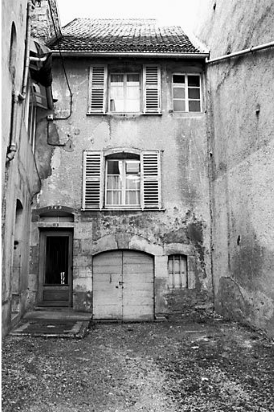
Façade antérieure sur cour.
