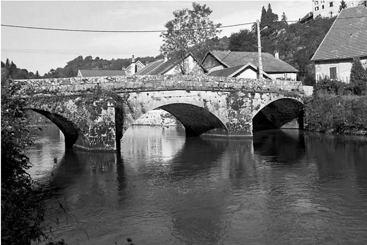
Vue depuis l'amont.
