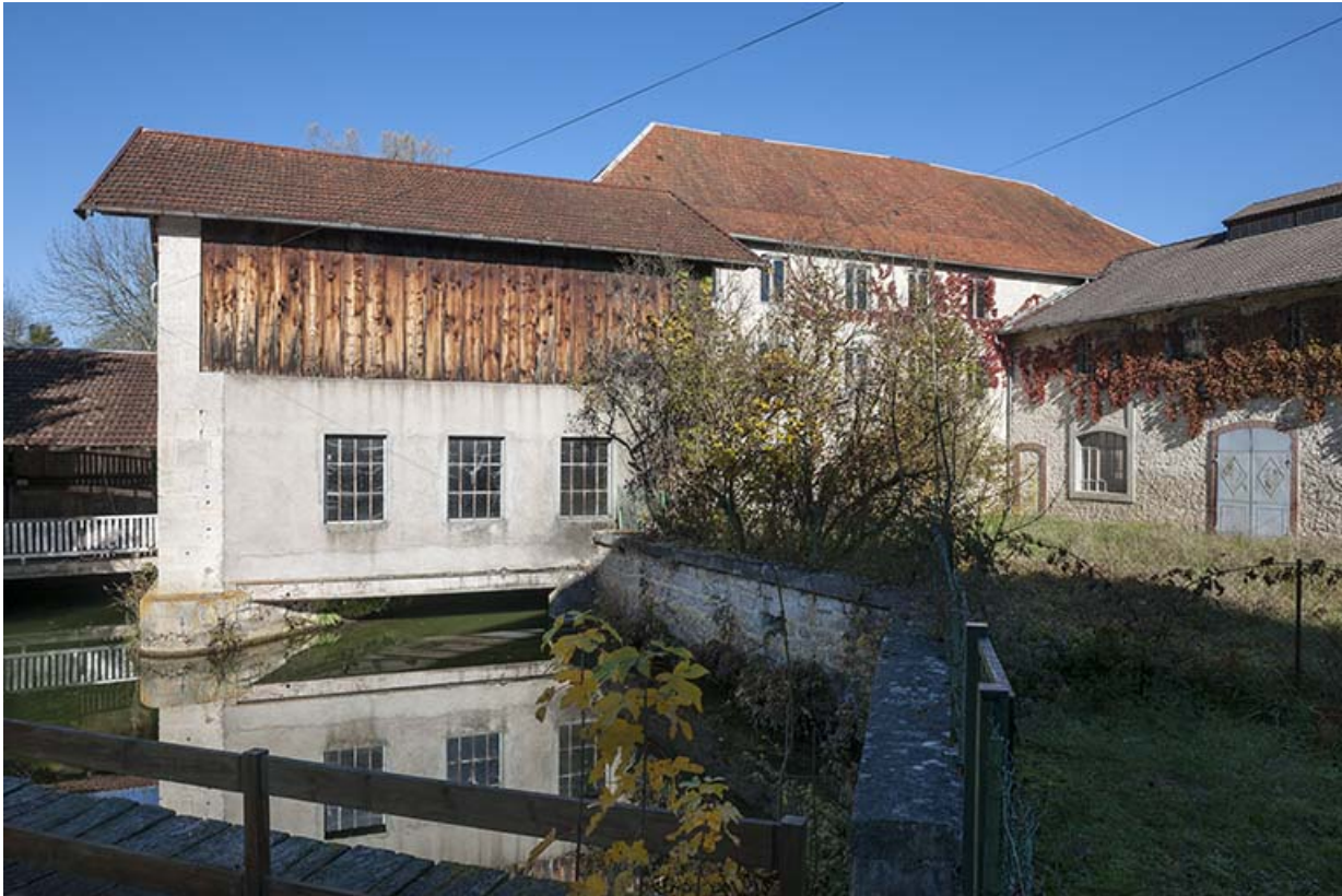
Bâtiment d'eau et atelier de fabrication.
