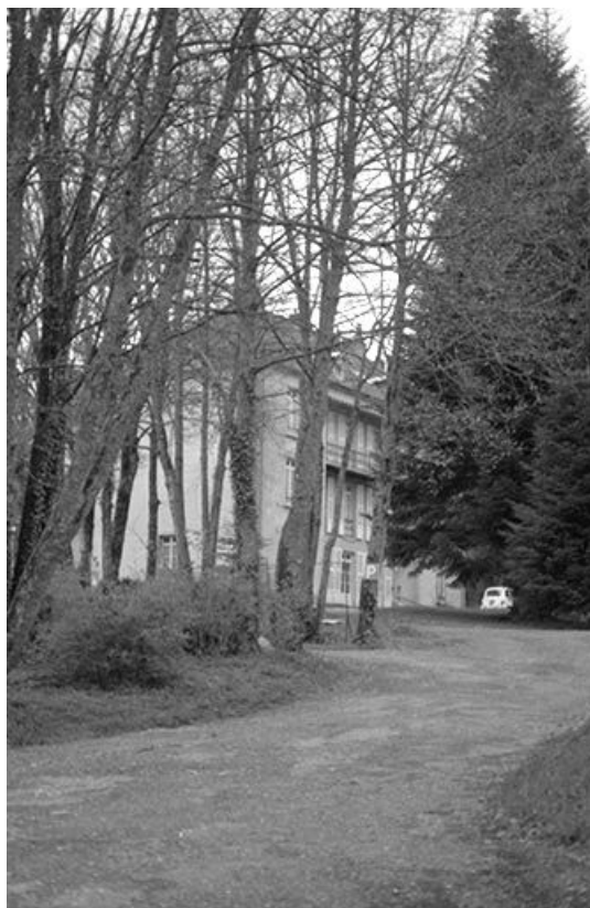
Façade antérieure et façade latérale gauche.
