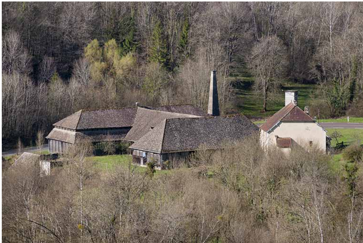
Vue plongeante depuis le nord-est.
