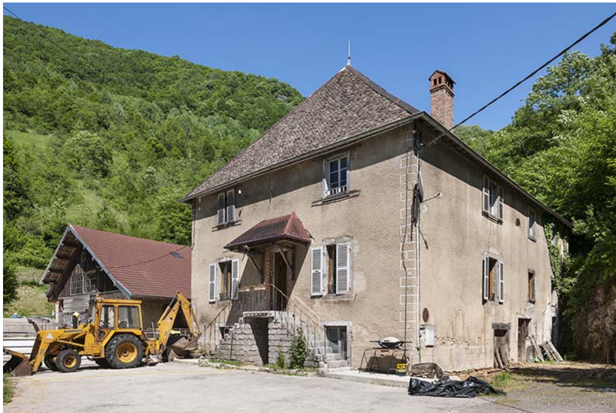
Atelier de scierie et logement patronal.
