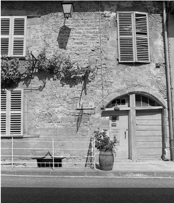
Détail de la façade antérieure : l'entrée.
