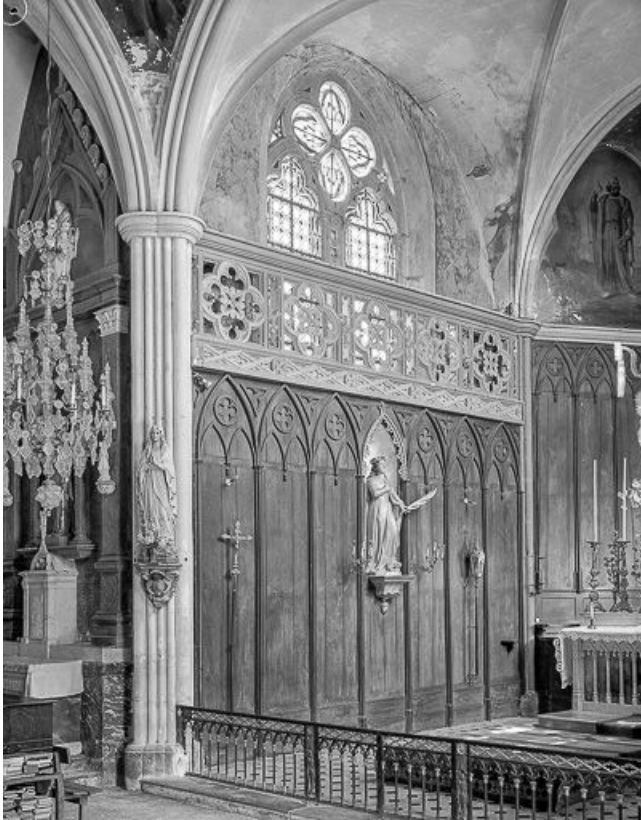
Intérieur : élévation gauche du chœur.
