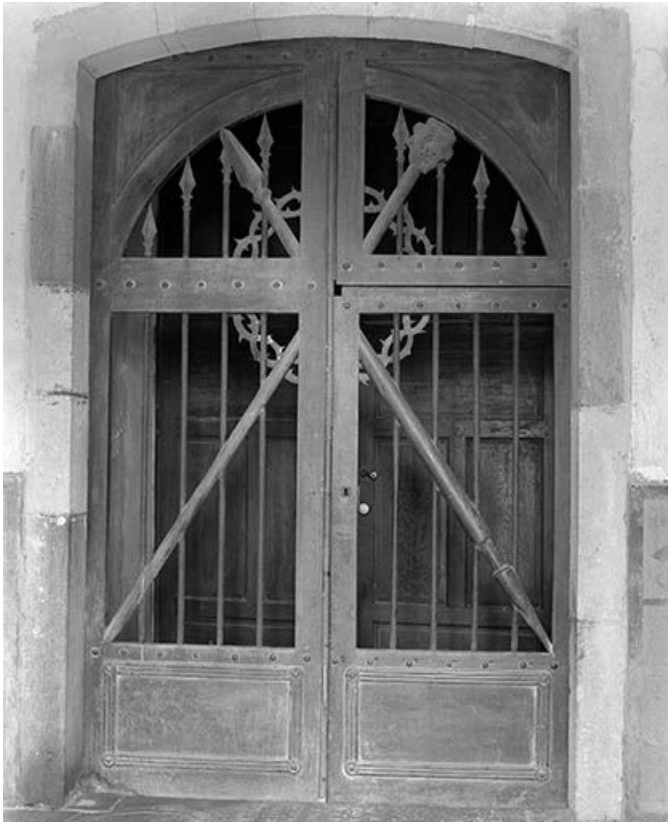
Porte conduisant à la nef.
