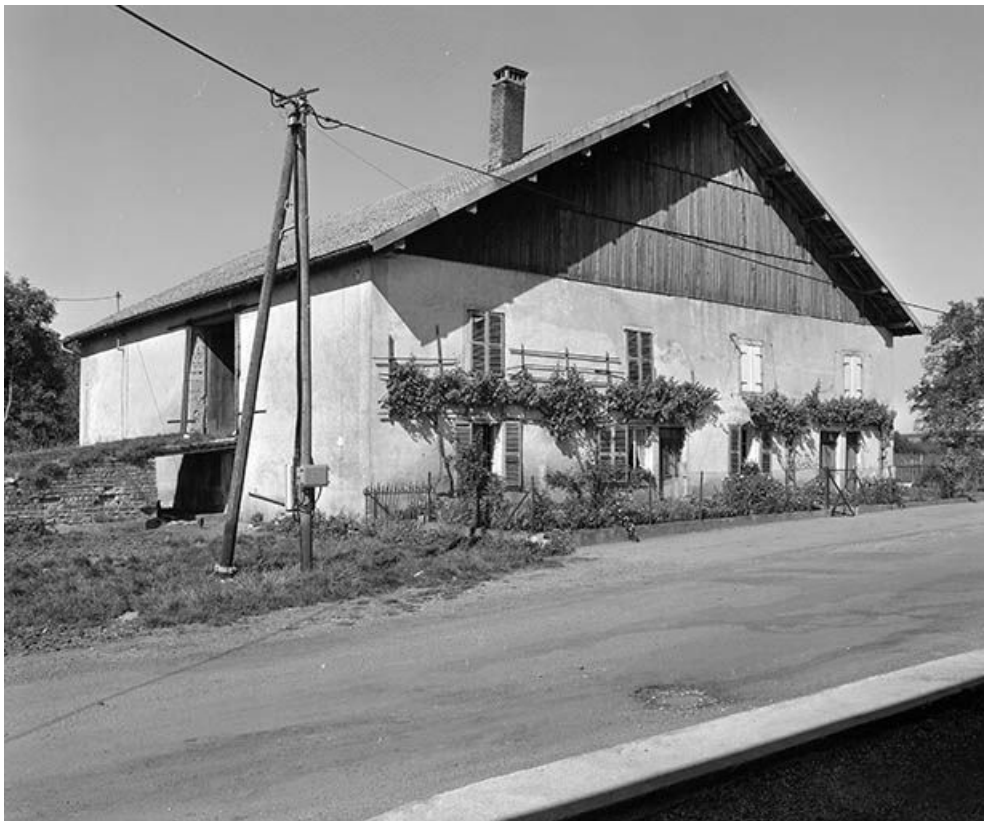
Façade antérieure et face latérale gauche. 25, Échevannes
