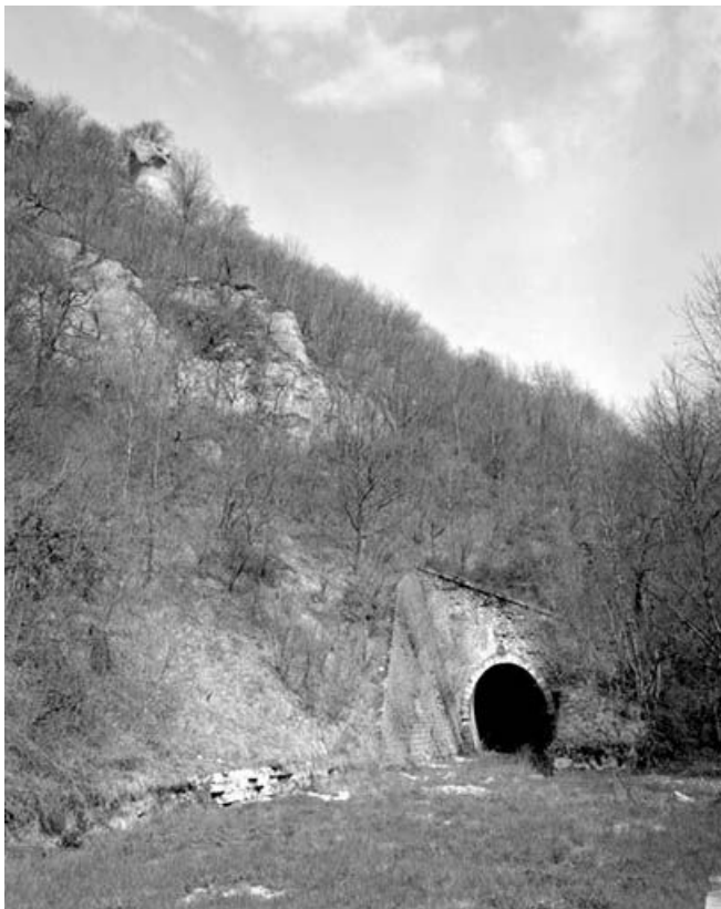
Bonnevaux-le-Prieuré : le tunnel.
