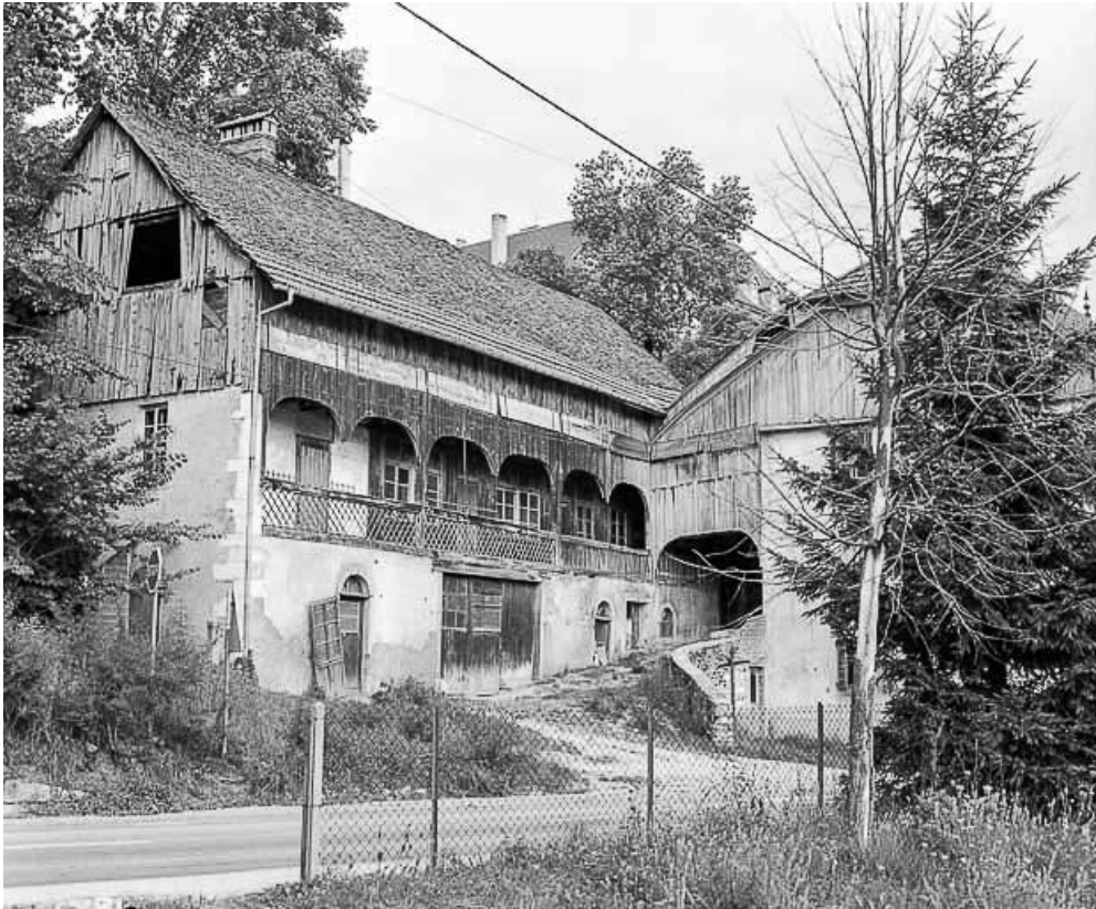
Détail : la galerie.
