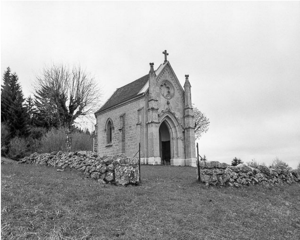
Vue d'ensemble éloignée.
