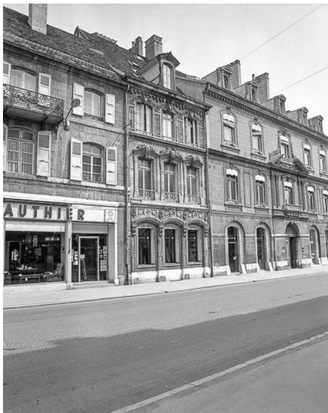
Façades sur rue.
