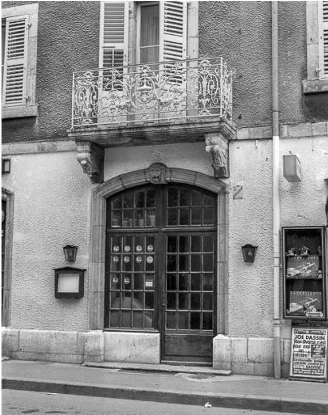
Porte d'entrée sur rue de la Gare.
