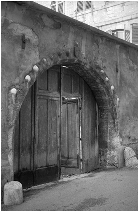
Porche de l'entrée sur la rue Parguez.
