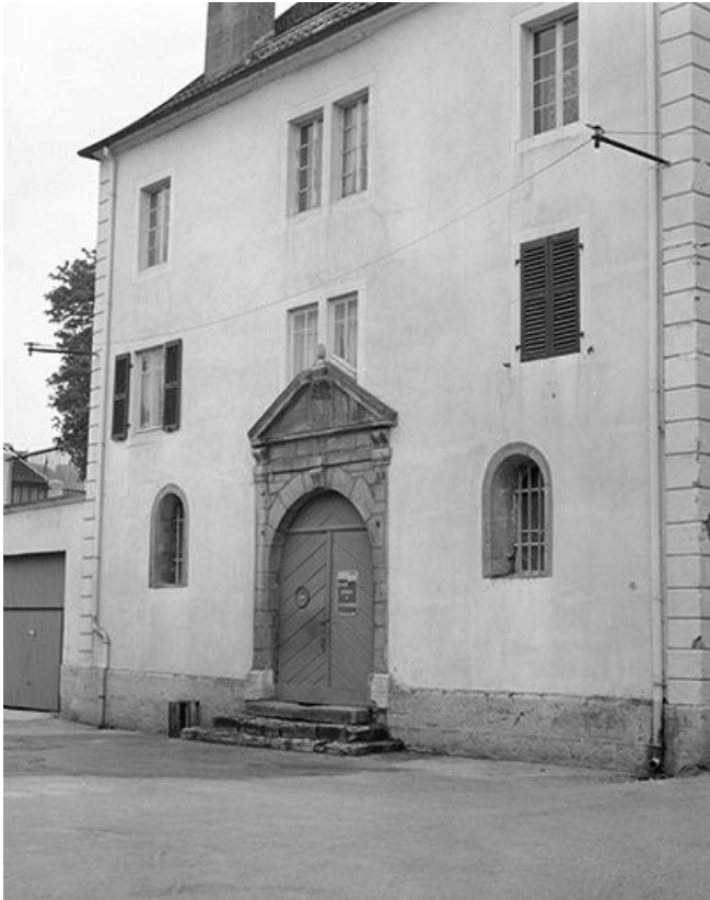
Façade sur la rue Jeanne d'Arc.
