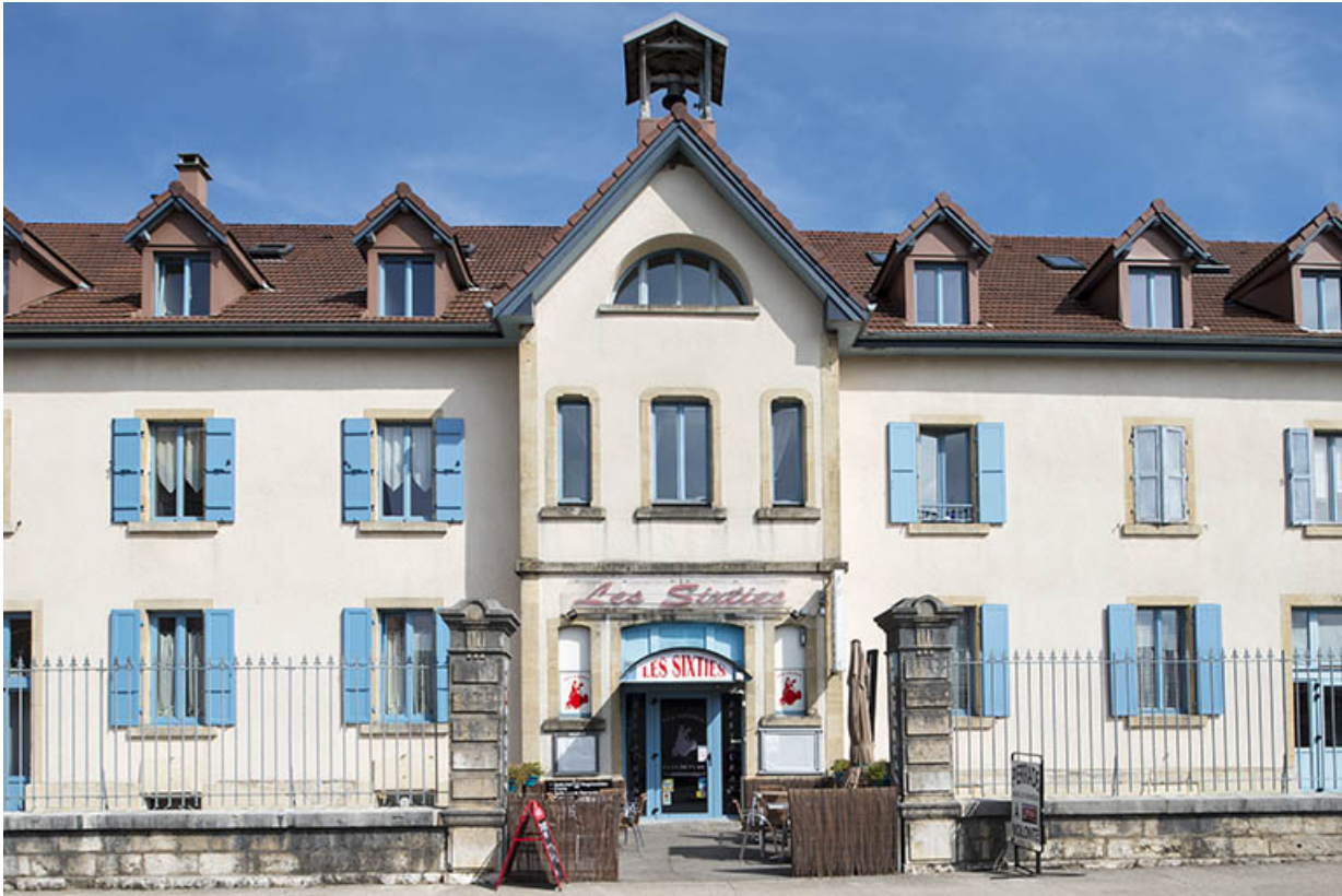
Partie centrale du bâtiment de la distillerie.
