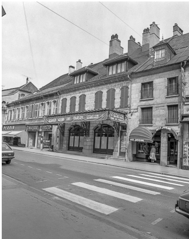
Façades sur rue.
