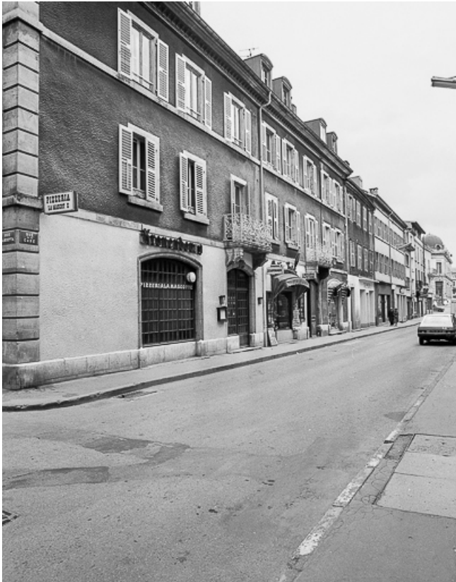
Façades sur rue.
