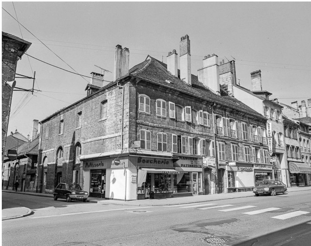
Façades sur rue.
