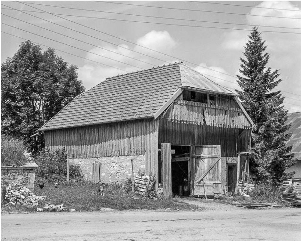
La remise, vue de trois quarts.
