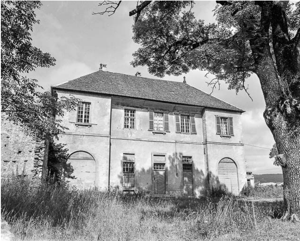
Façade sur rue. Vue de face.
