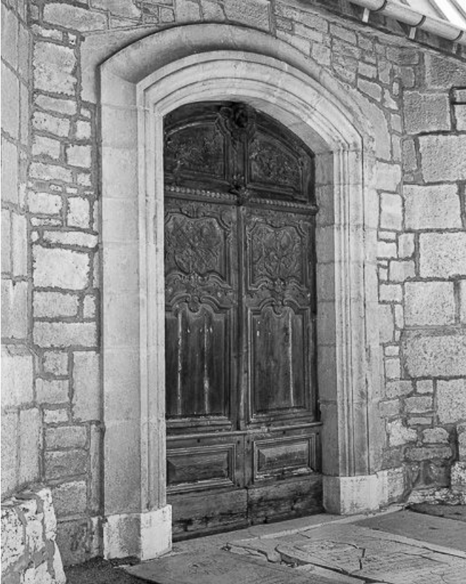
Vue d'ensemble de la première porte d'entrée.
