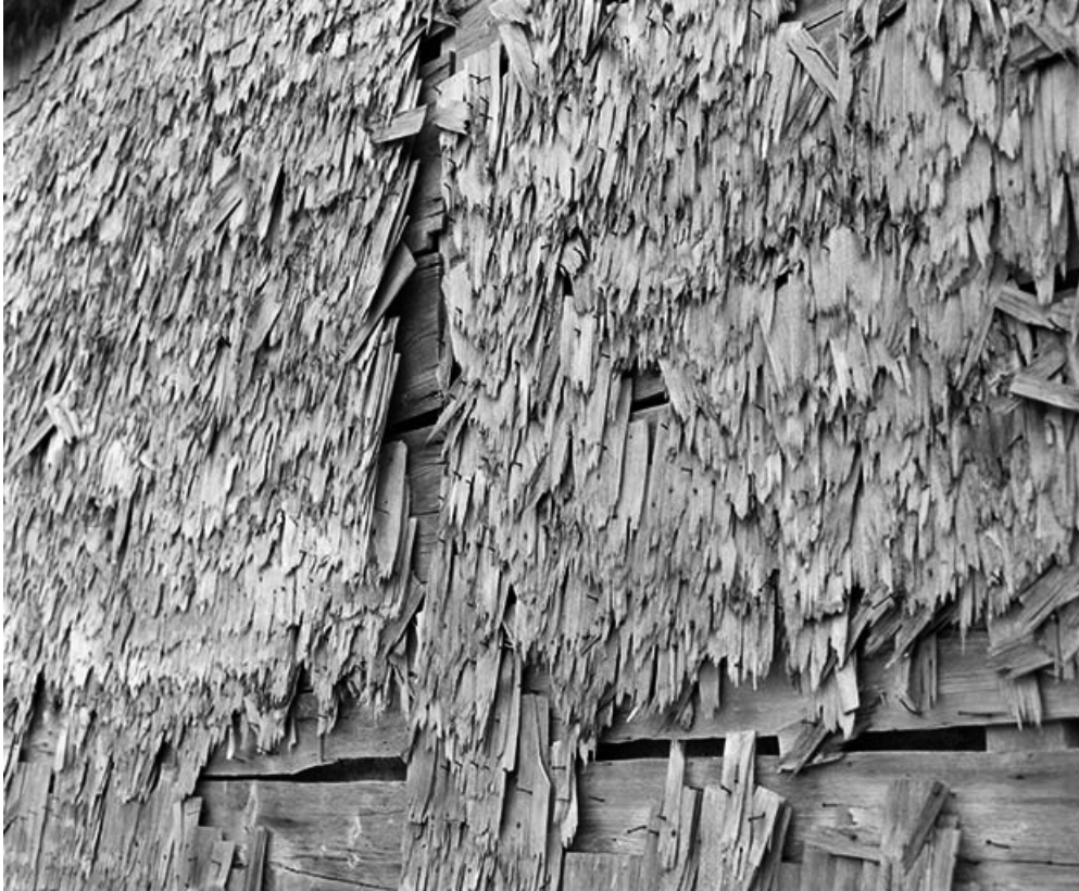
Tavillons de la façade latérale droite.
