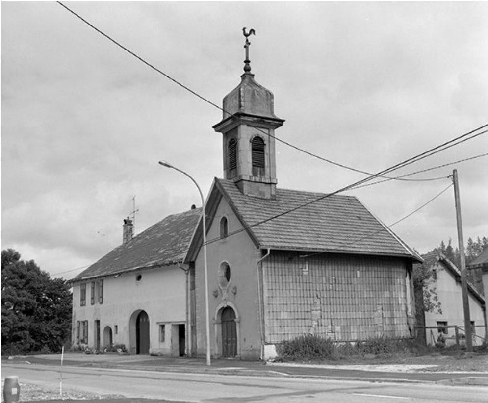
Façades antérieure et latérale droite.
