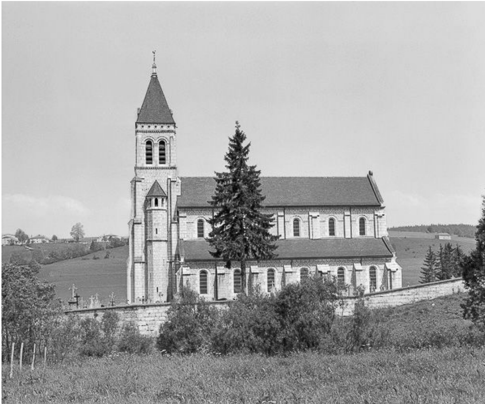
Façade latérale droite.
