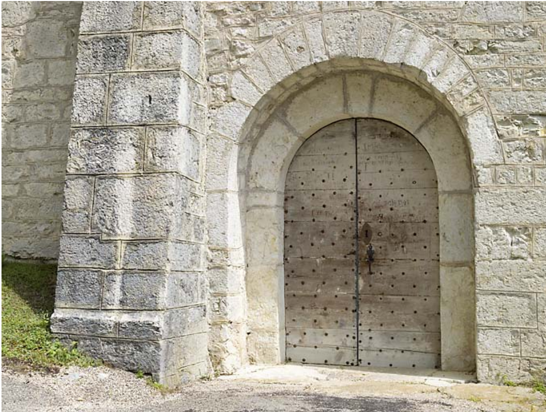
Façade sud : entrée.
