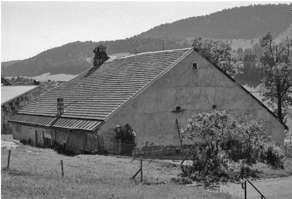
Façades postérieure et latérale gauche.
