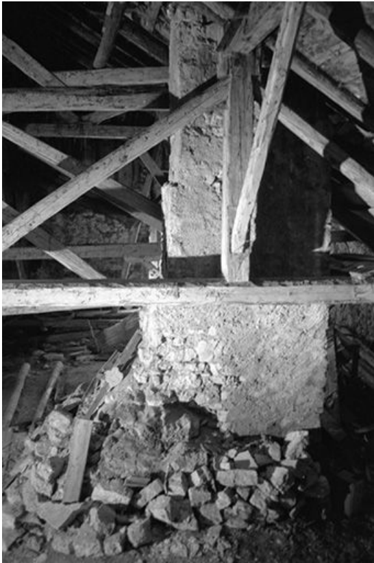
Intérieur : charpente et cheminée.
