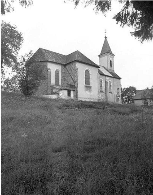
Façade latérale droite.
