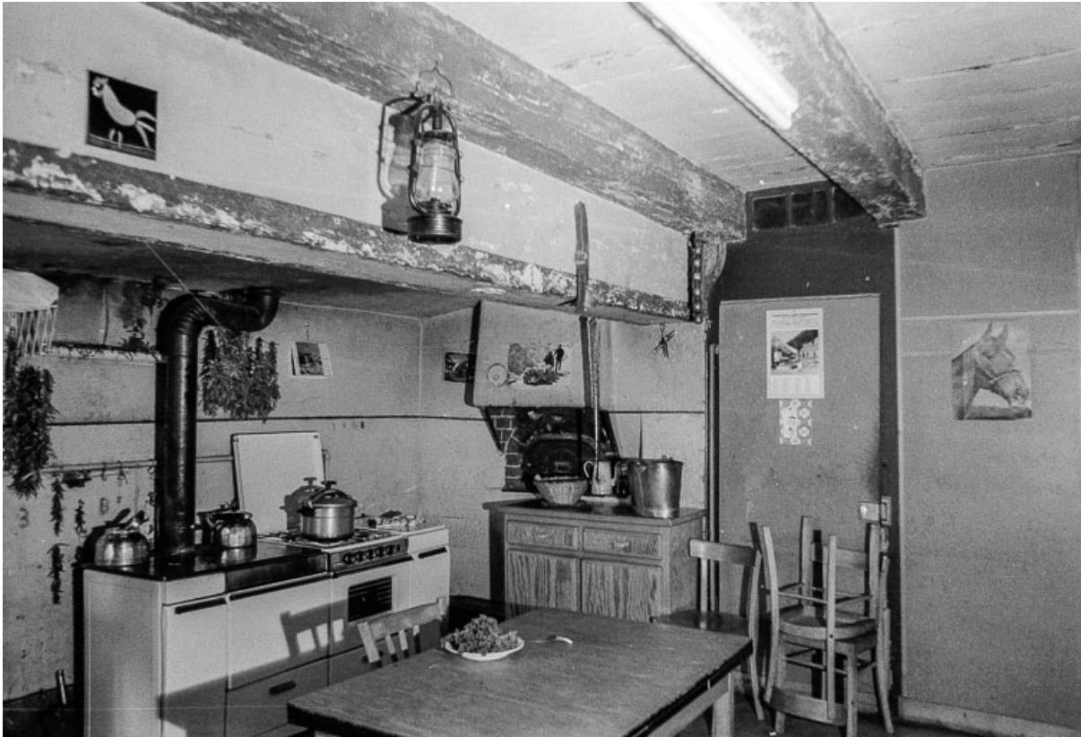
Cuisine : poutre supportant la cheminée.
