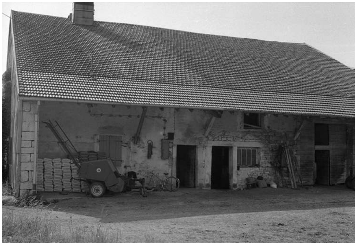
Façade latérale droite.
