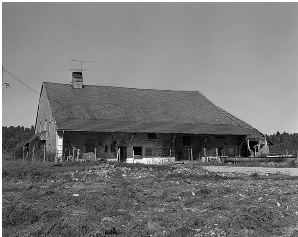
Façade latérale droite.
