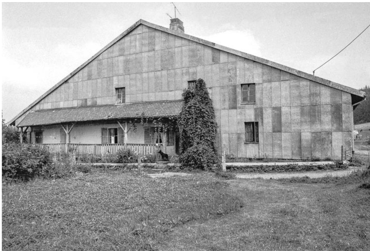
Façade antérieure vue de face.
