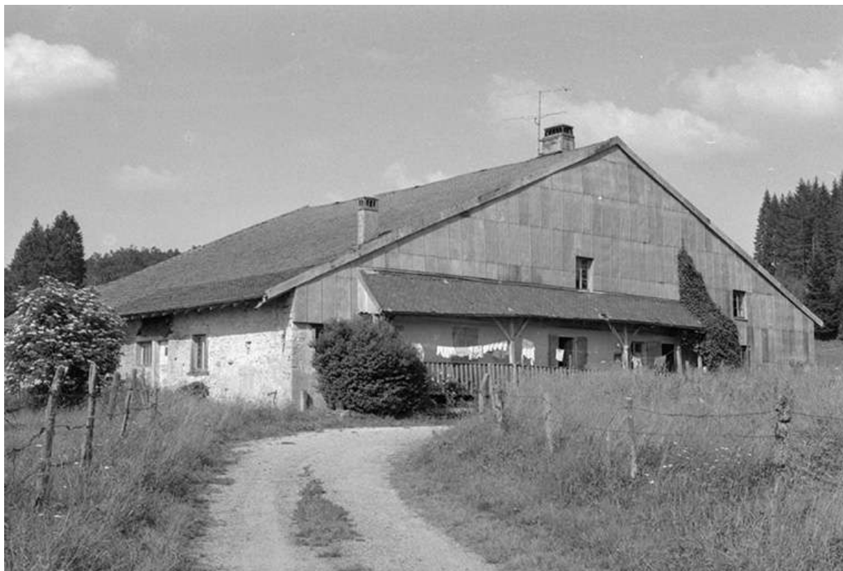
Façades antérieure et latérale gauche.
