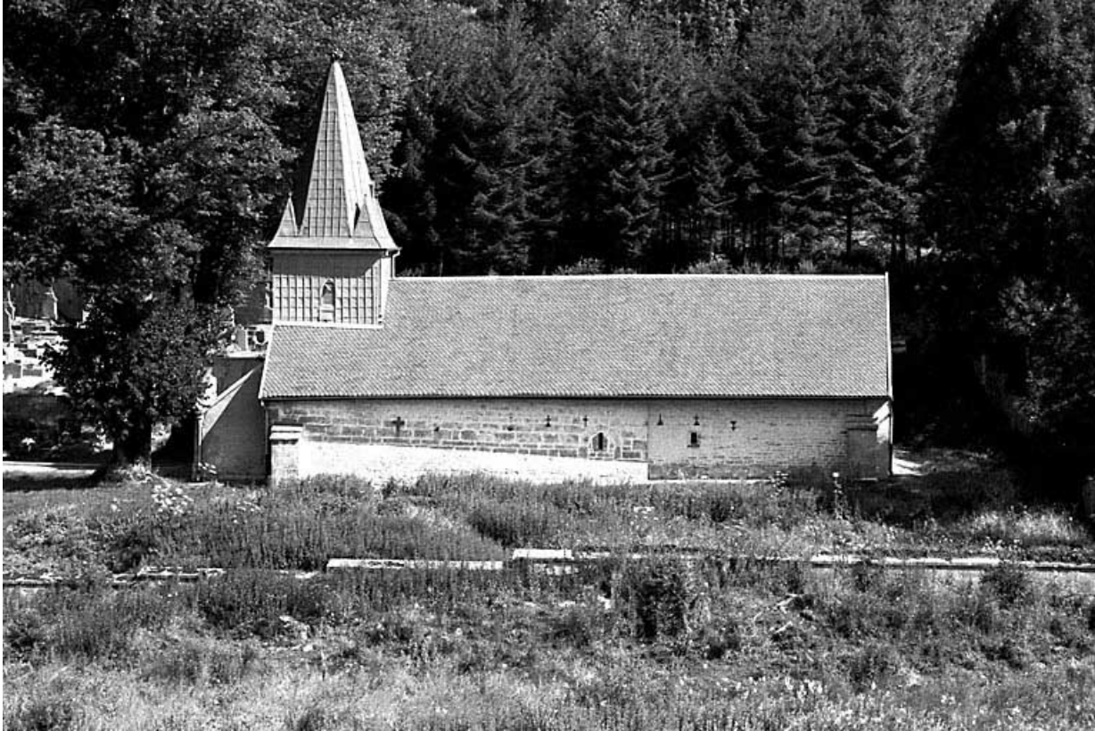
Façade latérale droite.
