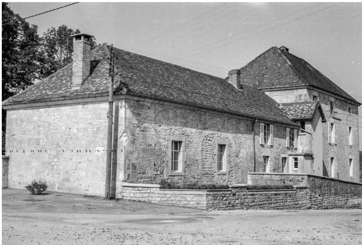
Façade sur la rue.
