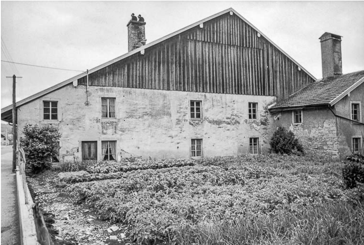
Façade antérieure et jardin.
