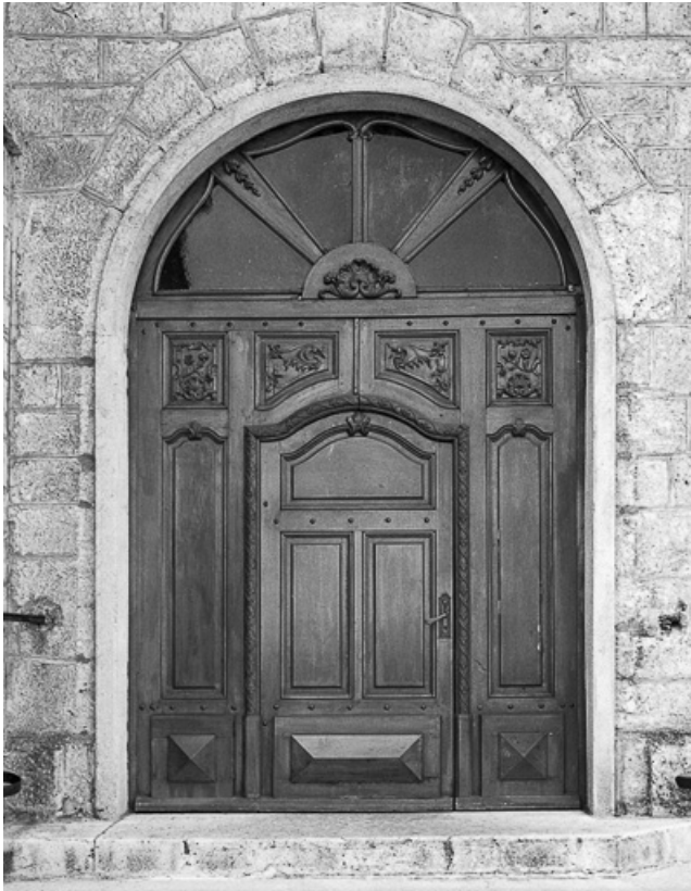
Porte d'entrée nord.
