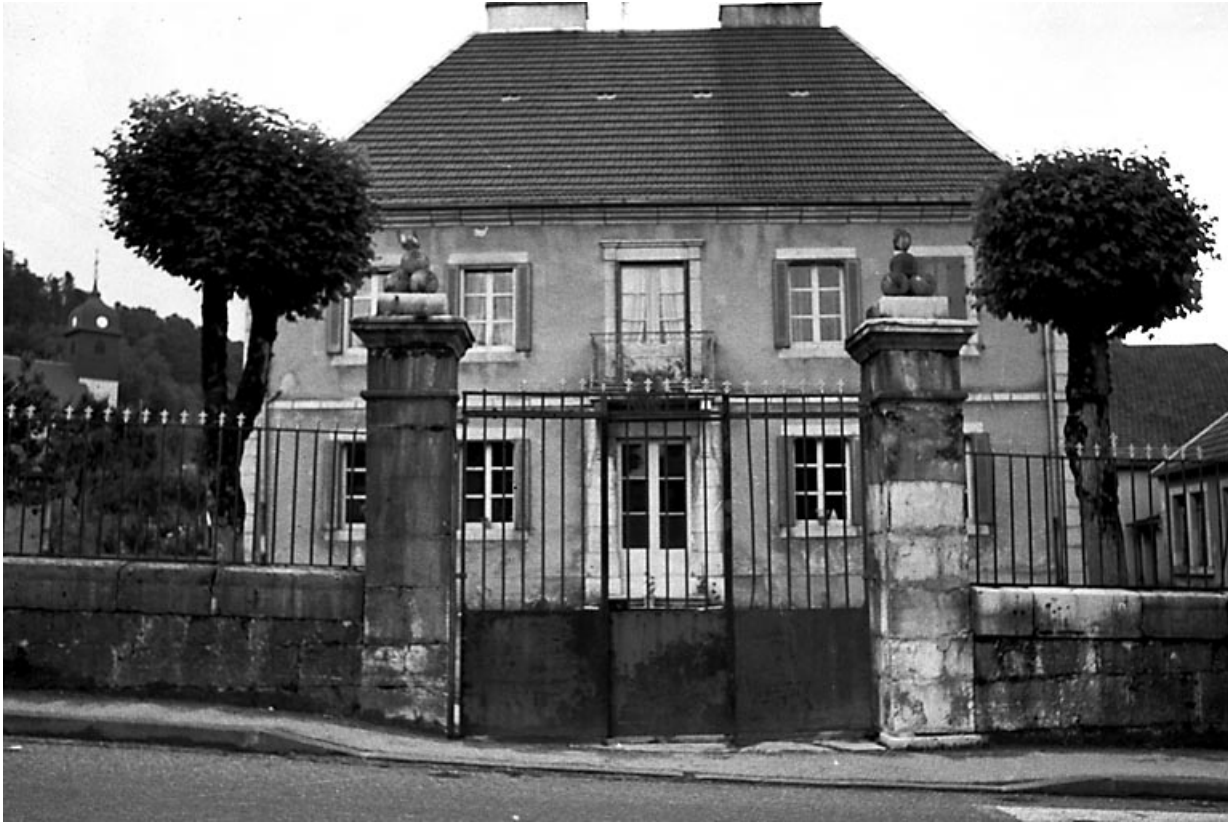
Façade antérieure et portail d'entrée.
