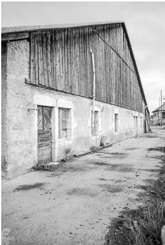
Ferme cadastrée 1962 E 11 : façade antérieure. 25, Sombacour
