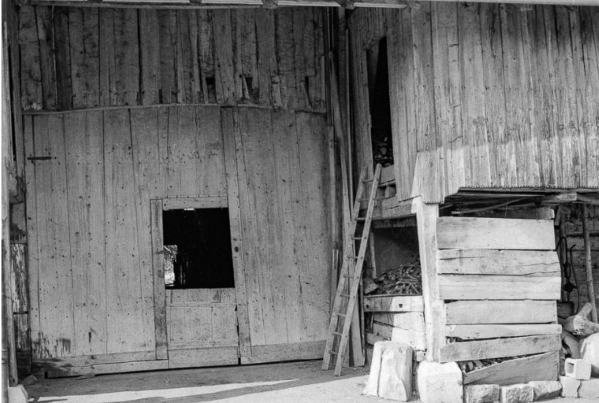
Ferme cadastrée 1962 E 174-175 : porte de grange et galerie en bois fermée servant de bûcher. 25, Sombacour
