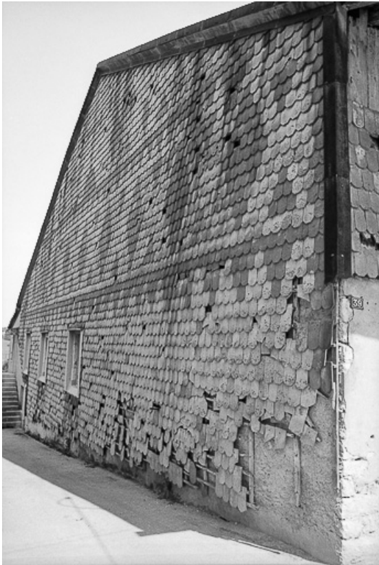
Ferme cadastrée 1962 E 106, 346-347 : façade avec tavillons. 25, Sombacour
