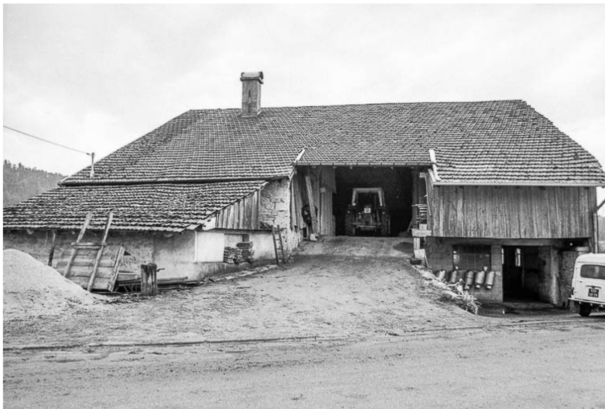
Ferme cadastrée 1962 E 11 : façade sur rue. 25, Sombacour
