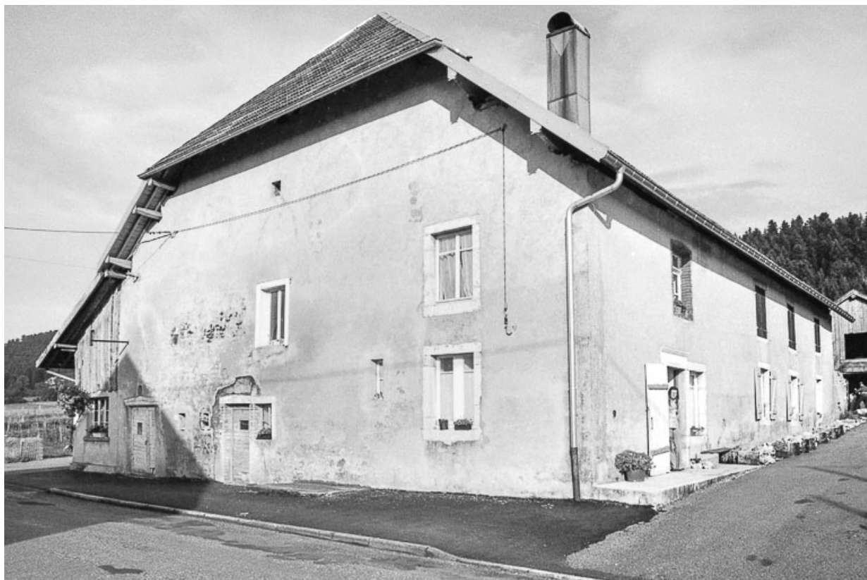
Ferme cadastrée 1962 E 109 : façade sur rue. 25, Sombacour
