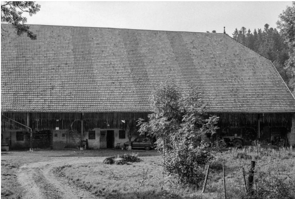
Façade latérale droite.
