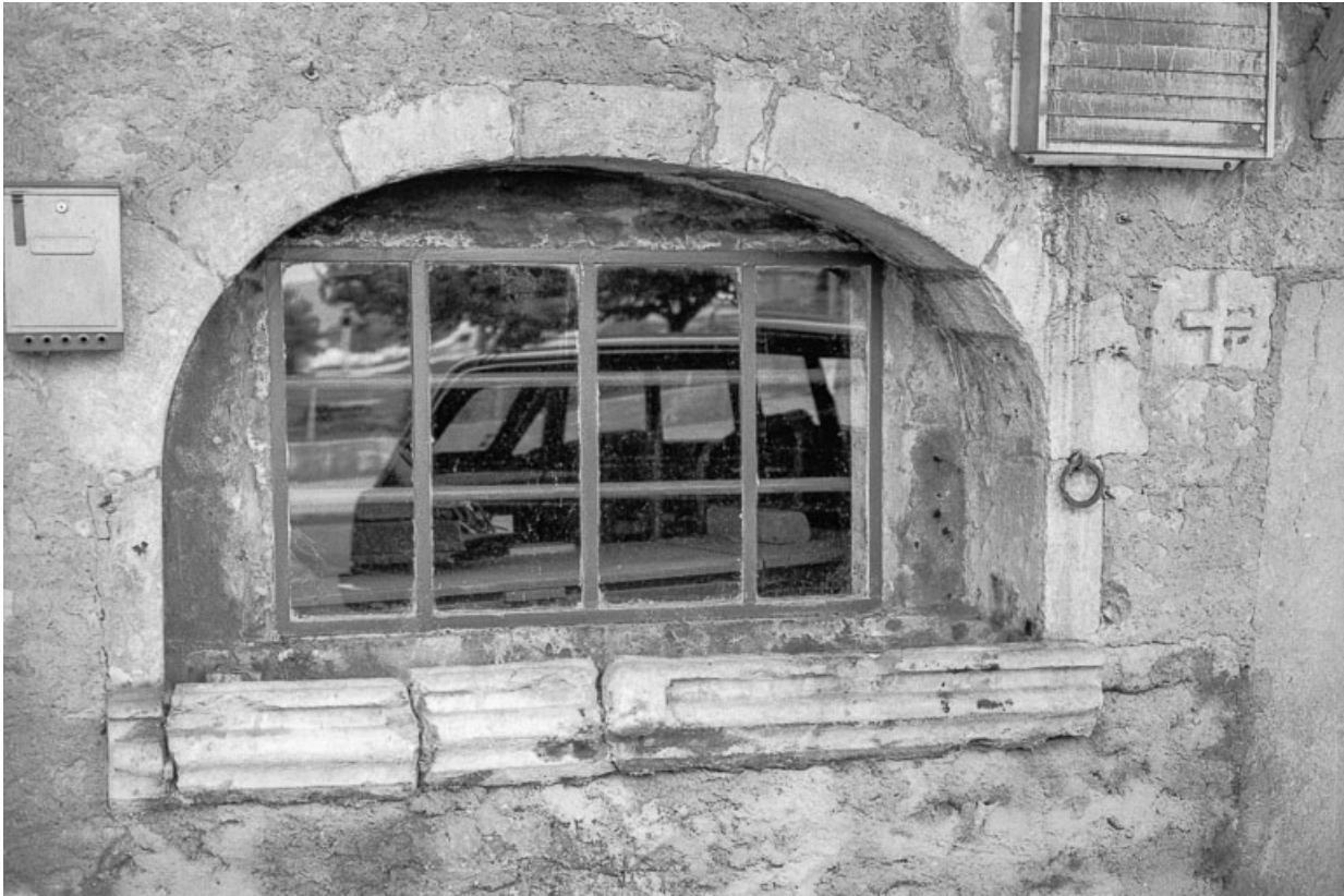
Fenêtre de l'écurie avec mangeoire.
