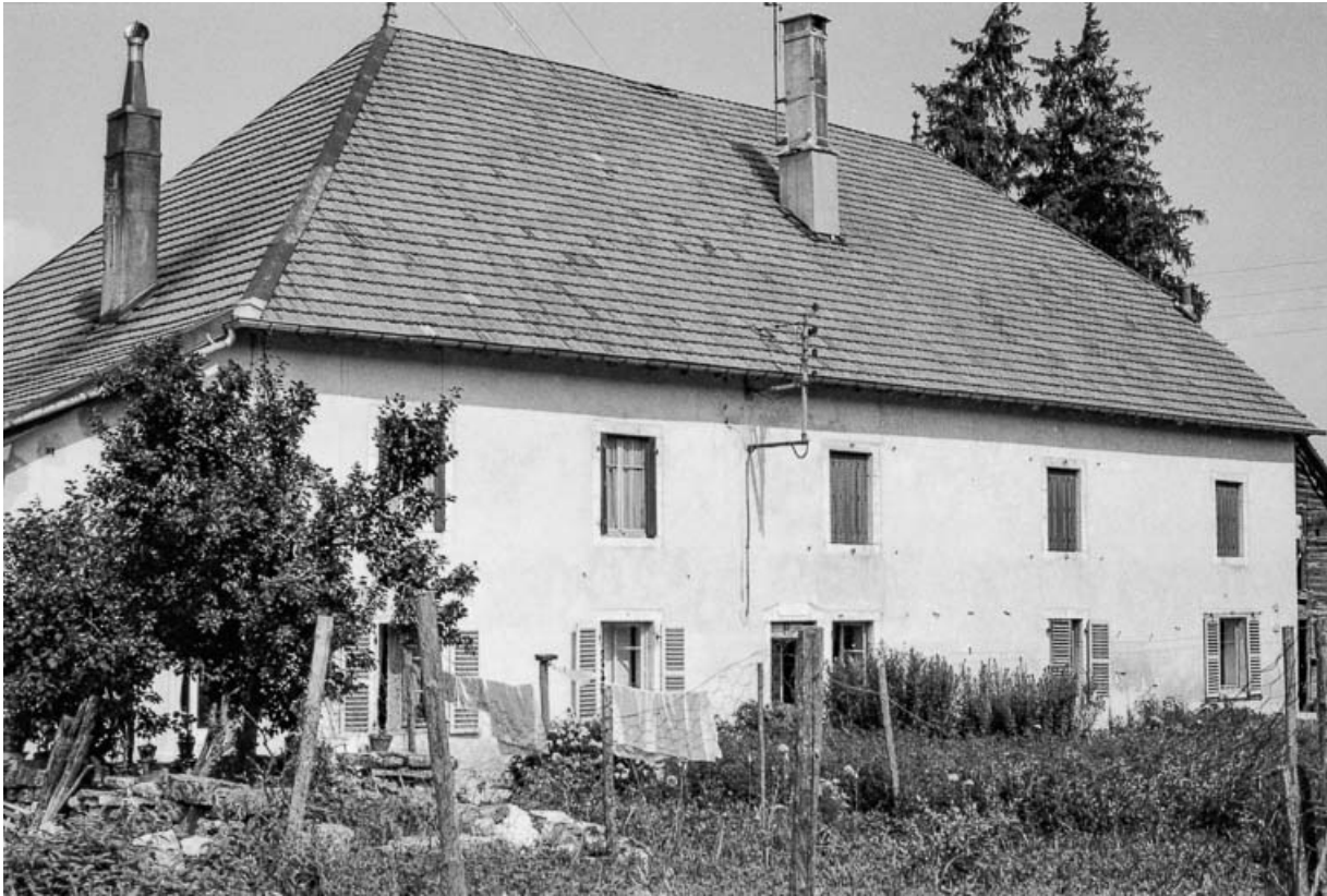
Ferme cadastrée 1964 D 25, 31, 31 bis, 33 : façade antérieure.
