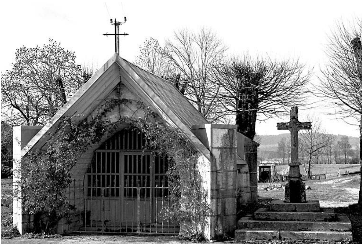
Façade antérieure et croix monumentale.
