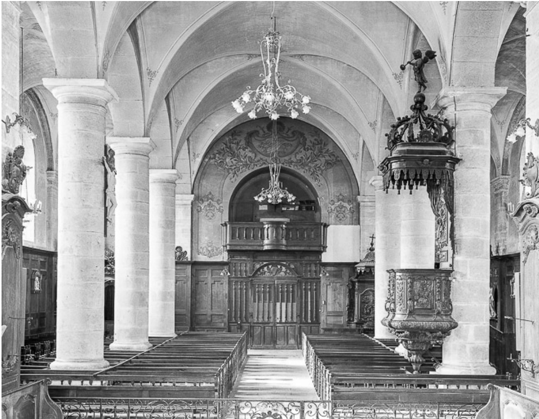
Nef vue depuis le chœur.
